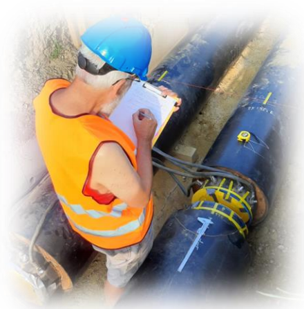
Obr. 7 Příklad propojování potrubí elektro-ohřevem
